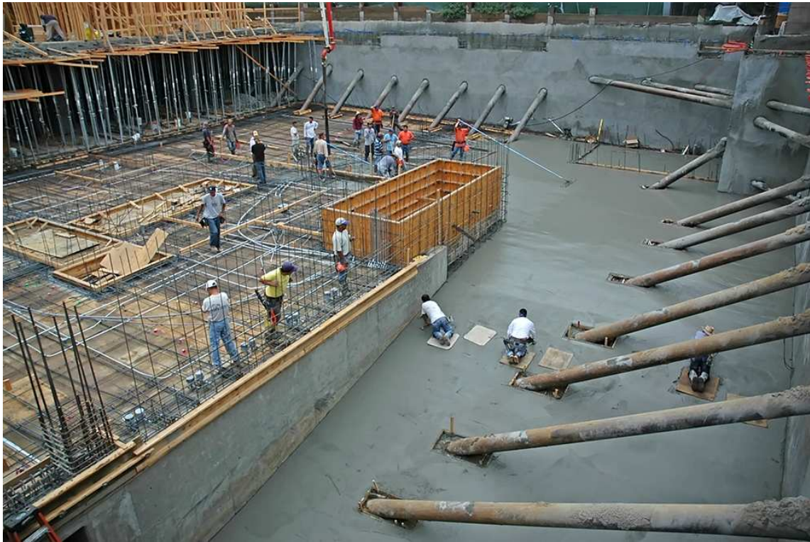
Foto 6: Elamu keldrikorruse ehitamine Hollywoodis. Korrusmajad ehitatakse monoliit-raudbetoonist.
