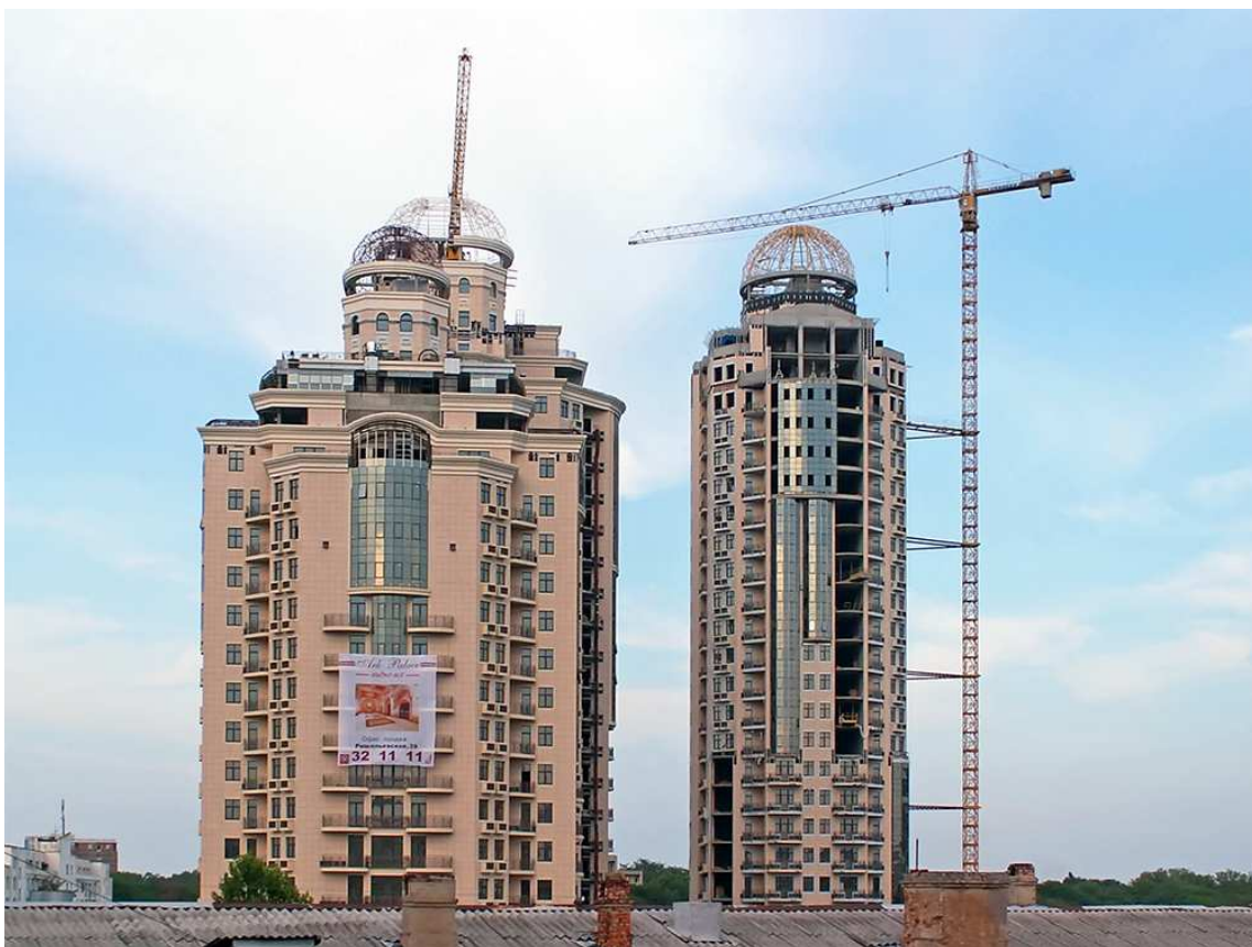
Foto 1: Vaade Odessa üliõpilaselamu rõdult. Ehitustegevust võis seal kohata tõesti igal sammul.
